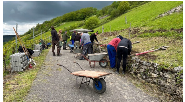
Abbildung 15: Teilnehmende des Trockenmauerkurses bei der Sanierung eines kaputten Mauerabschnittes.
