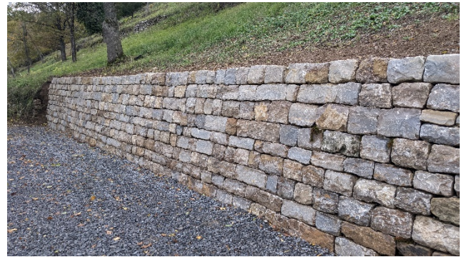
Abbildung 11: Nach der Sanierung ist die Mauer höher und die Mauerkrone etwas flacher. Die Pflege des ehemaligen Weinbergs ist somit wieder einfacher durchzuführen.
