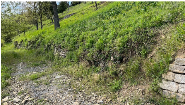
Abbildung 10: Nur noch einzelne Steine sind an der Trockenmauer am Altenberg in Möglingen vorhanden.
